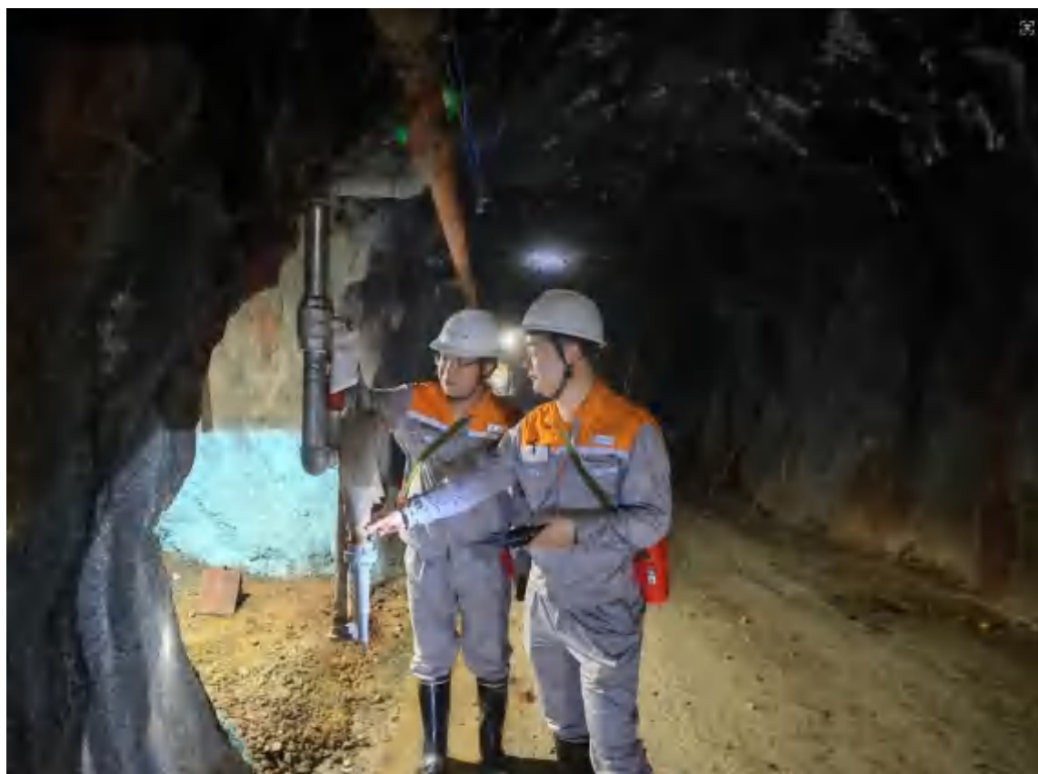
图6.1-2 检查斜坡道消火栓照片
