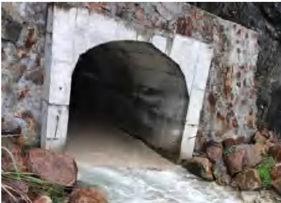
图 2.5-4 库内隧洞一出口
