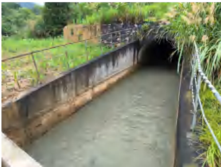
图 2.5-12 库外排洪隧洞出口明渠
