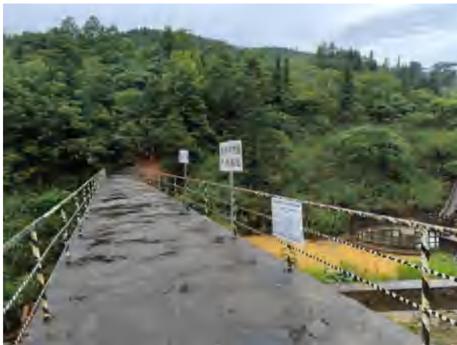
图 2.5-8 1号拦洪坝、1号排水竖井
