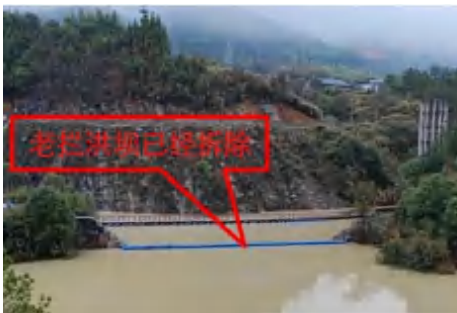
图 2.5-6 老拦洪坝位置
