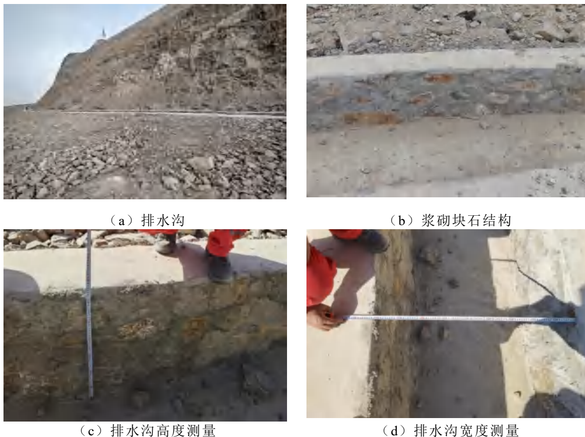
图 2-21 +1741m 平台排水沟
