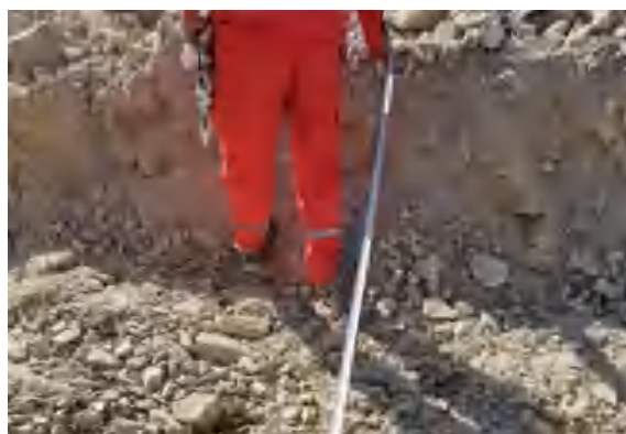
(f) II号—IV号排土场排水沟宽度测量
