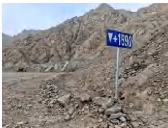
(a) II 号—IV 号排土场+1590m 截排水设施
