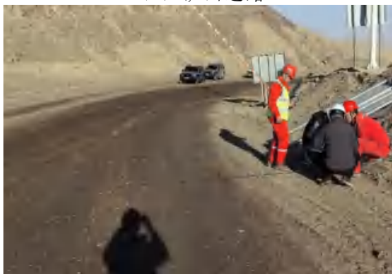
(e) 道路宽度测量
