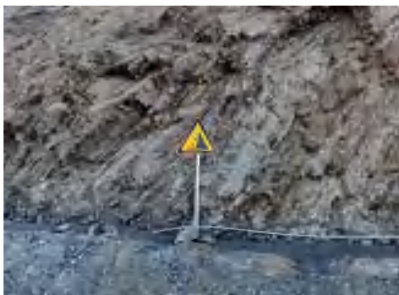
(c) 道路边坡安全标志
