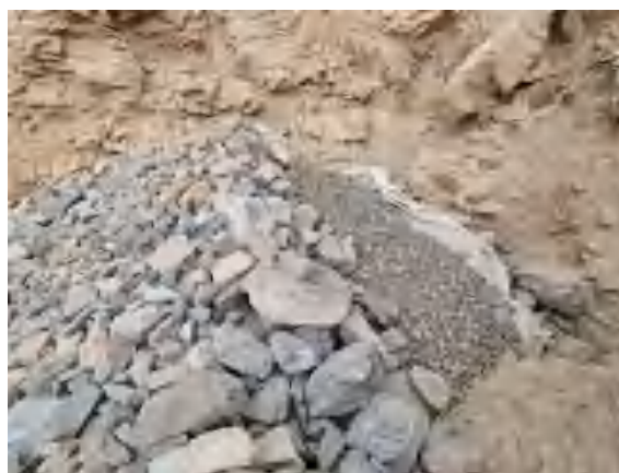
(b) II 号—IV 号排土场排渗盲沟
