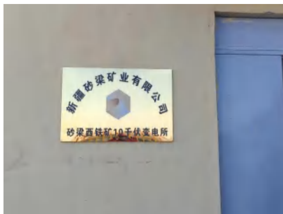
(b) 10kV 变配电所
