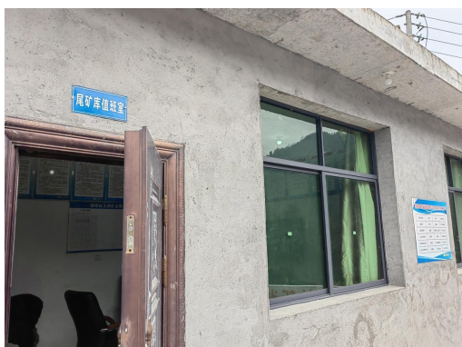
图 2.6-19 位于库区左侧值班室
