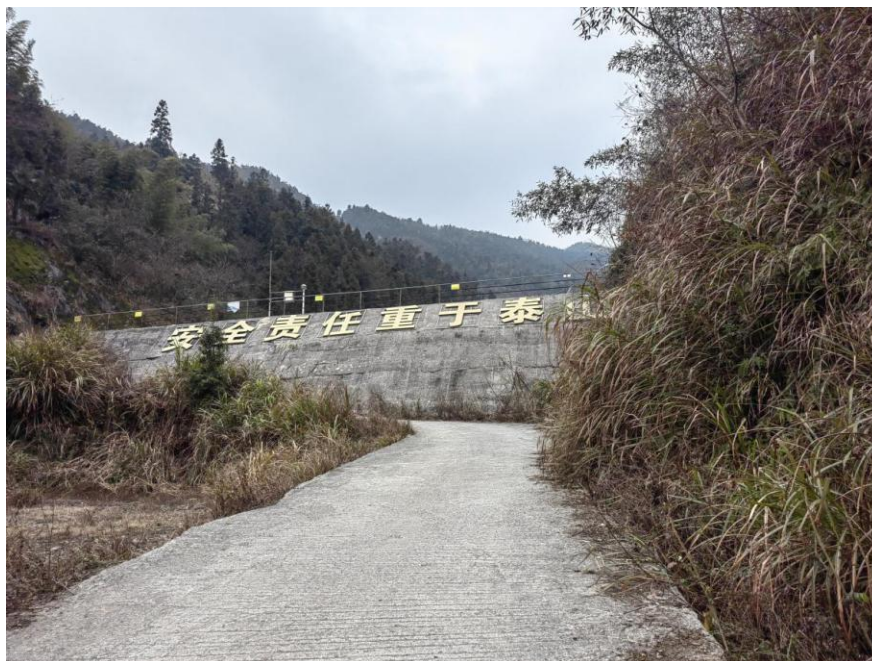
图 2.6-4 株梓洞尾矿库库尾拦洪坝（下游侧）
