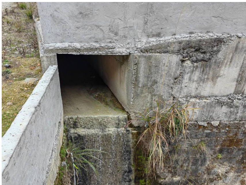
图 2.6-9 株梓洞尾矿库库外清水管出口明渠
