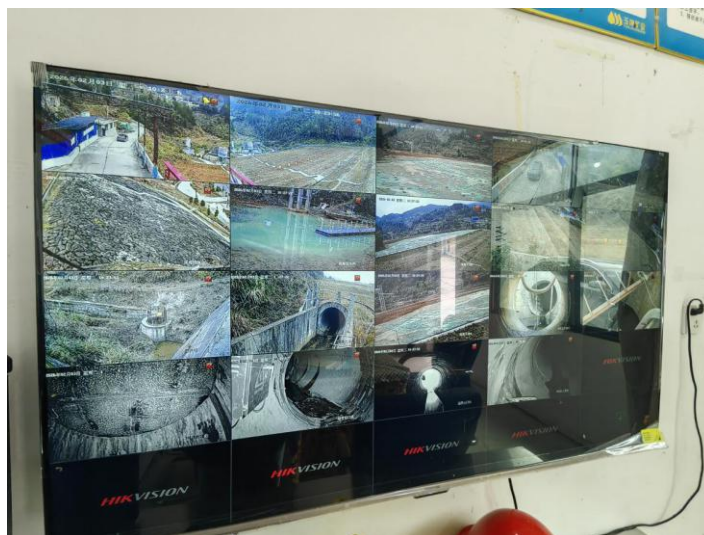
图 2.6-13 株梓洞尾矿库视频监控
