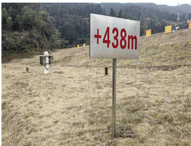
图 2.6-2 株梓洞尾矿库堆积坝**m 平台
