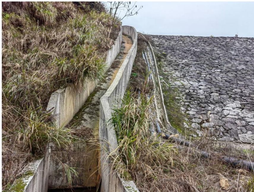
图 2.6-8 株梓洞尾矿库库内排洪系统出口明渠（位于库区右坝肩侧）
