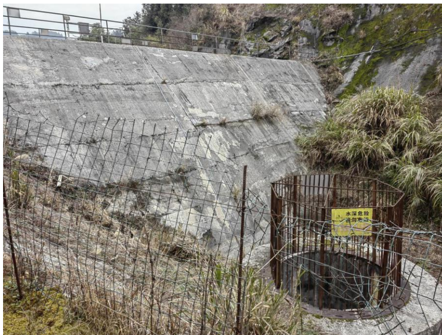
图 2.6-5 株梓洞尾矿库库尾拦洪坝（上游侧）
