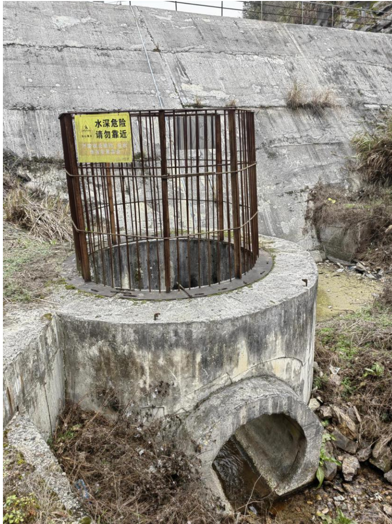
图 2.6-10 株梓洞尾矿库拦洪坝前溢流井
