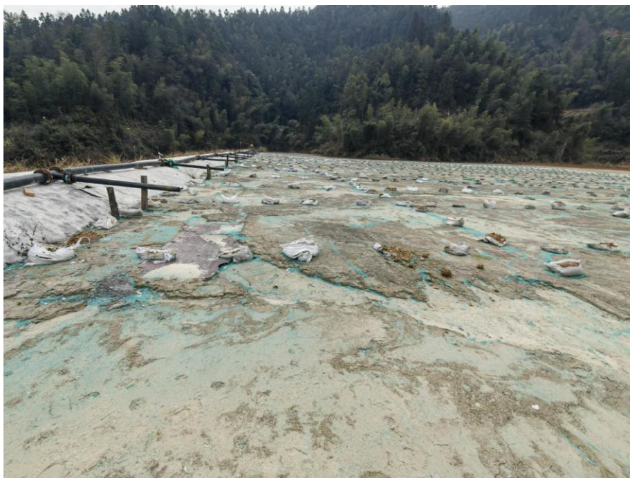
图 2.6-11 株梓洞尾矿库库内沉积滩面
