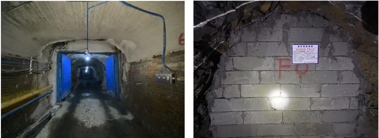
图 2-12 通风构筑物安装现状
