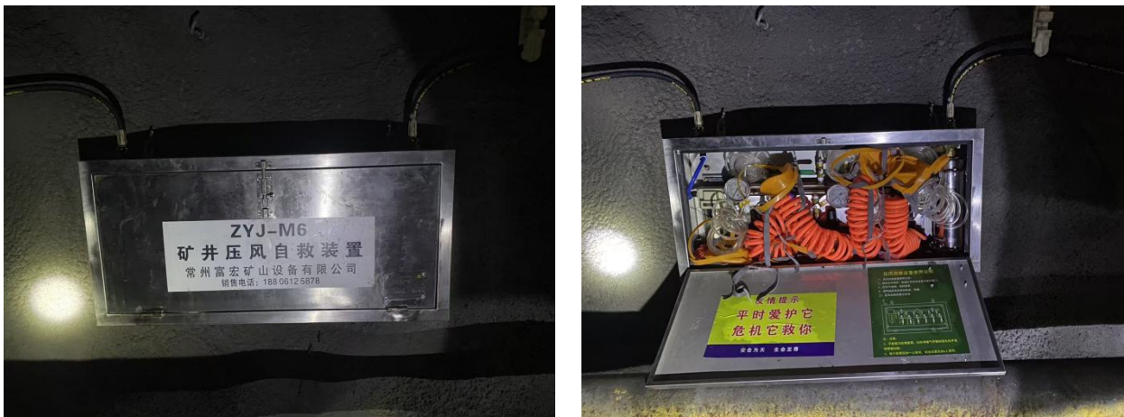
图 2-24 ZYJ-M6 型矿井压风供水自救一体装置
