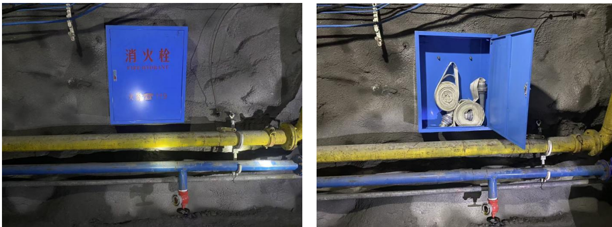
图 2-18 消火栓布置现状
