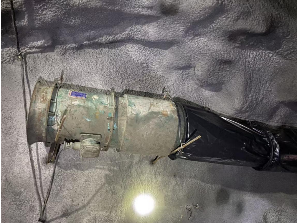
图 2-11 局部通风机安装现状
