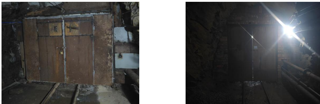
图 2-29 通风构筑物安装现状
