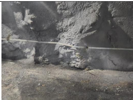
图 2-48 接地干线
