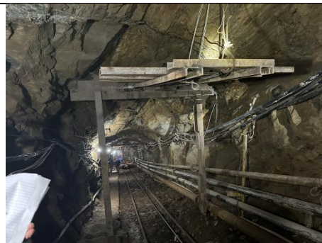
图 2-16 2 号盲斜井防跑车装置
