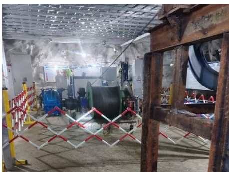
图 2-11 1 号盲斜井提升机房
