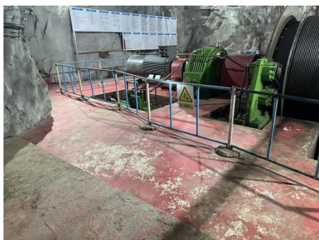
图 2-17 3 号盲斜井提升机房
