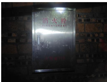
图 2-34 消火栓布置现状
