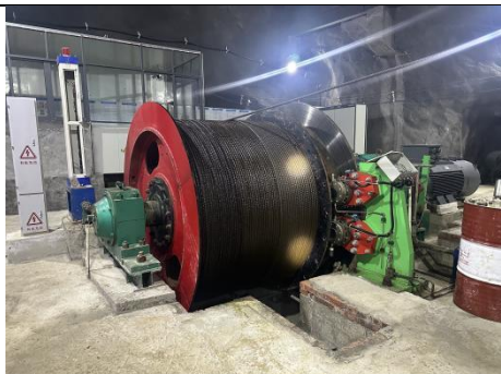
图 2-15 2 号盲斜井提升机房
