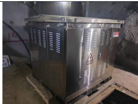
图 2-45 KKSG-200-/10/0.4 型变压器
