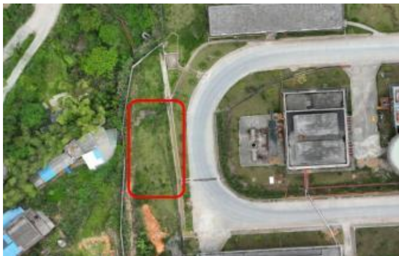
图 2-7 白钨尾砂输送泵房站址
