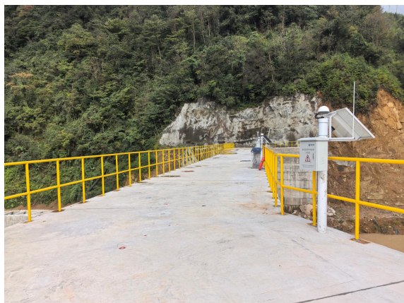
图 2.5-24 1#截洪坝处监测设施
